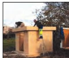
*Construction d'un abri route de Marsac pour protéger les installations et limiter le bruit des pompes de relevage vers la station.*
