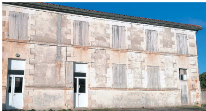
Le bâtiment principal accueillera la salle de restauration
